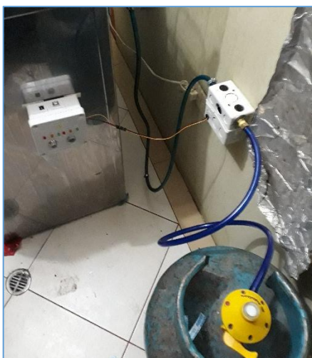
Figura 12-3. Nodo Router actuador ubicado. Realizado por: SEGURA Alex, 2017
