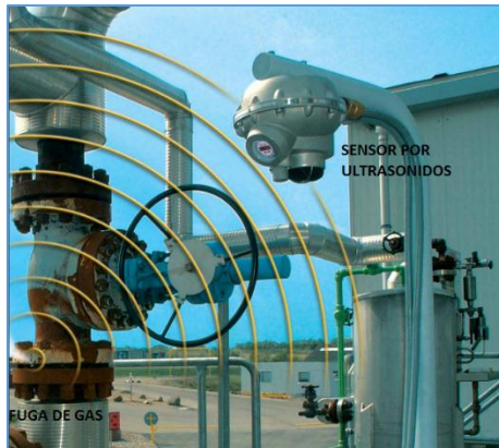
Figura 4-1. Detección por ultrasonidos. Fuente: (MSA International, 2012)
