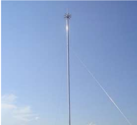
Figura 49-2: Pararrayo instalado
