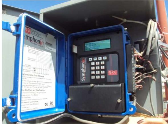
**FOTOGRAFÍA 1 Y 2. ESTACIÓN METEOROLÓGICA SYNPHONIE DATA RETRIEVER**
