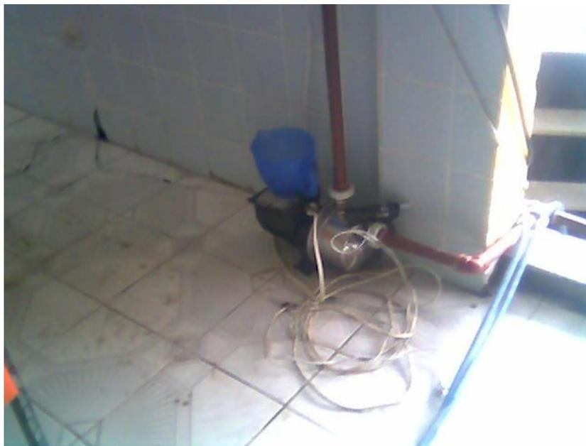
Dentro de la planta de producción se tienen tres bombas de similares características, las mismas que son utilizadas para extraer e impulsar el vino de tanque a tanque.
