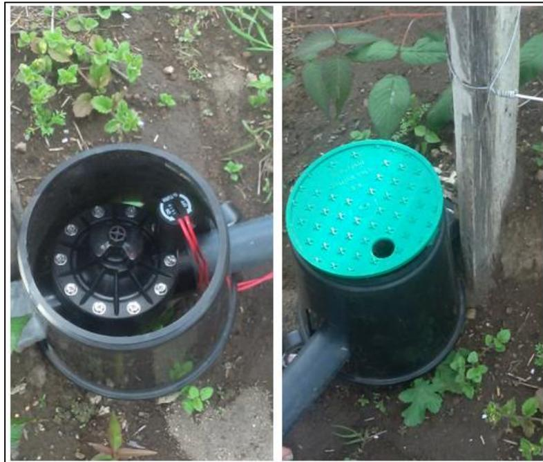
Figura 43-3 Instalación de las electroválvulas
