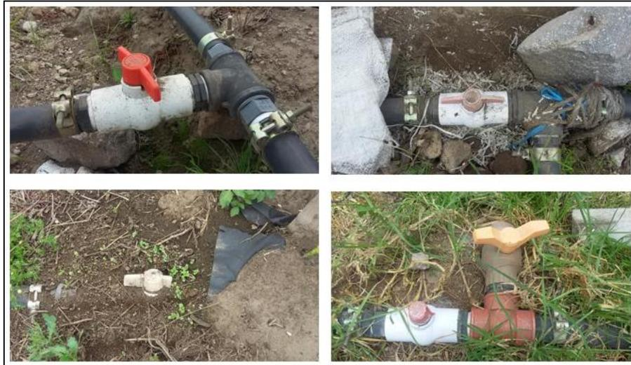
Figura 12-3 Válvulas de paso manuales instaladas en el terreno.
