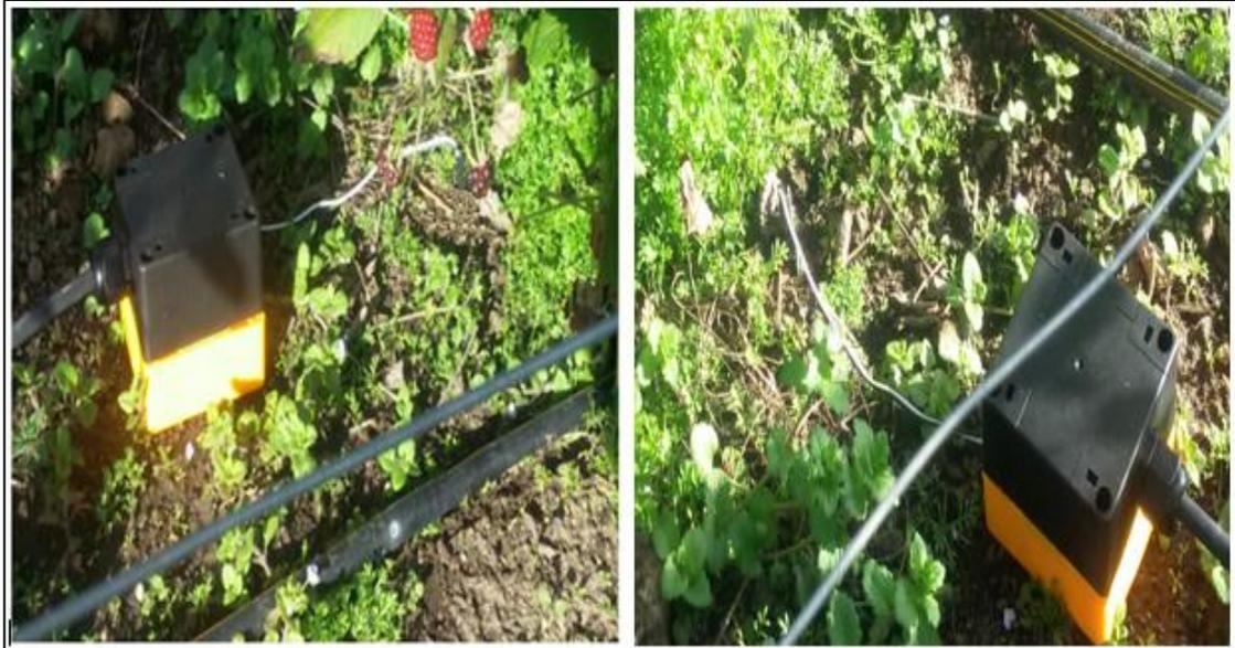
Figura 41-3 Instalación de sensores de humedad
