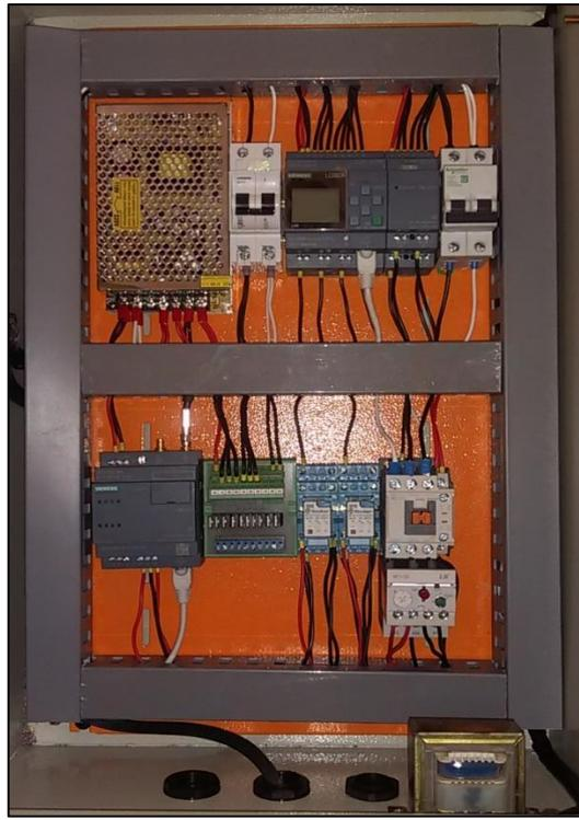
Figura 38-3 Tablero de control cableado
