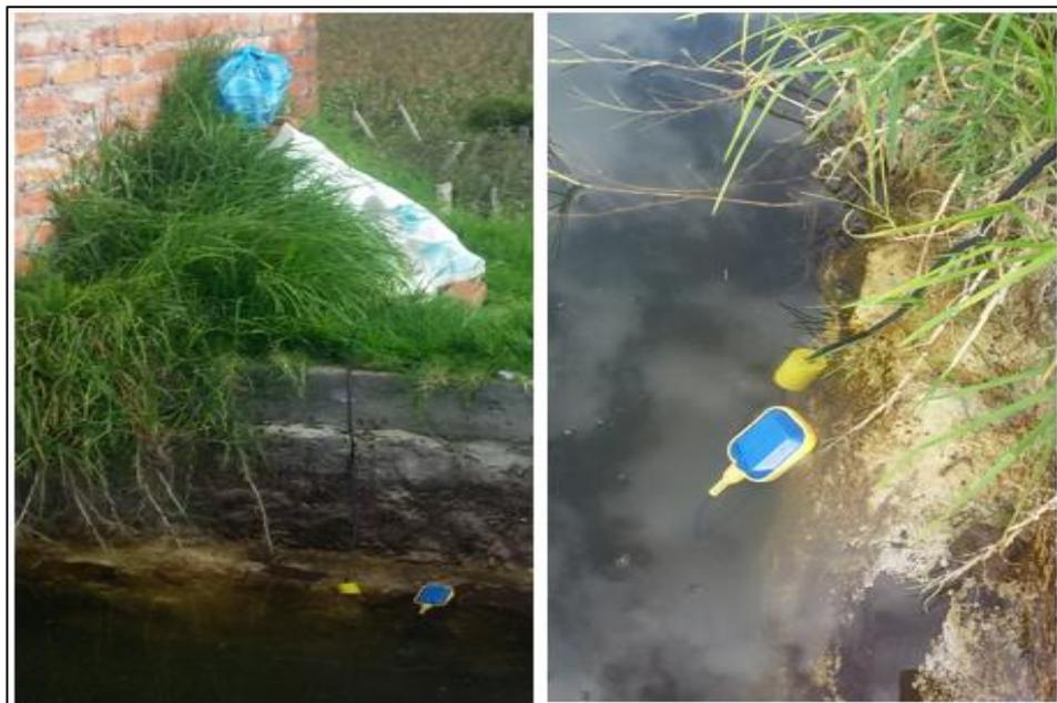
Figura 42-3 Instalación de sensor de nivel
