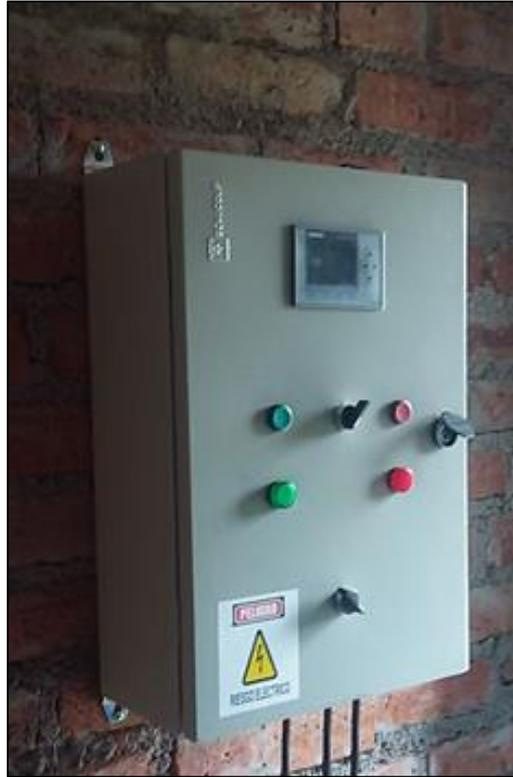
Figura 40-3 Instalación del tablero de control
