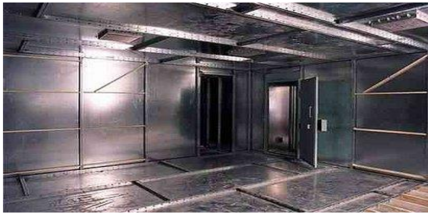
Figura 14-3: Blindaje Lámina de Acero con Tornillos
