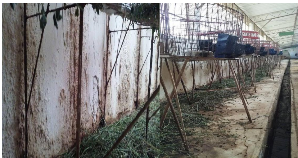
Fotografía 3. Interior del galpón cunícola
