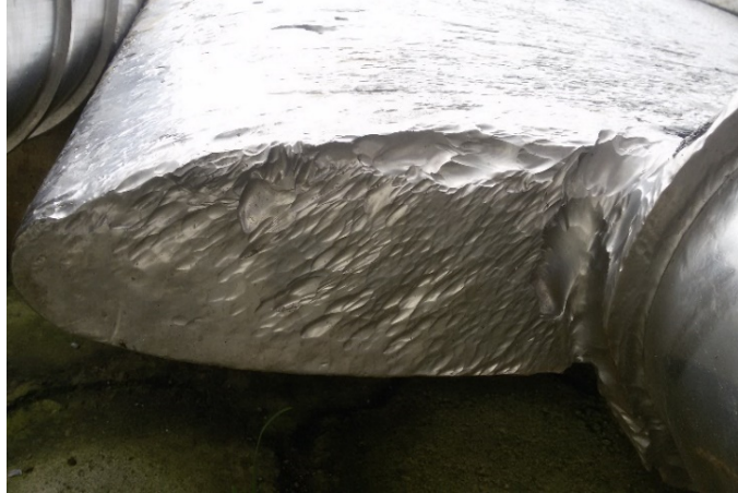
Figura 40. Daños sobre el lado lateral de la bandera de un álabe directriz
