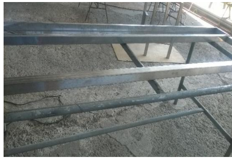
Figura.4-5: Estructura soldada a la base soporte.
