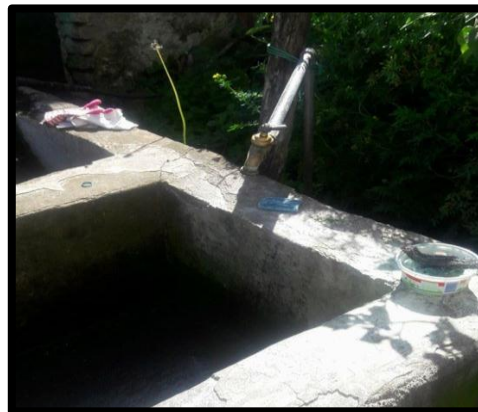
Figura 4-2: Vivienda del Sector
