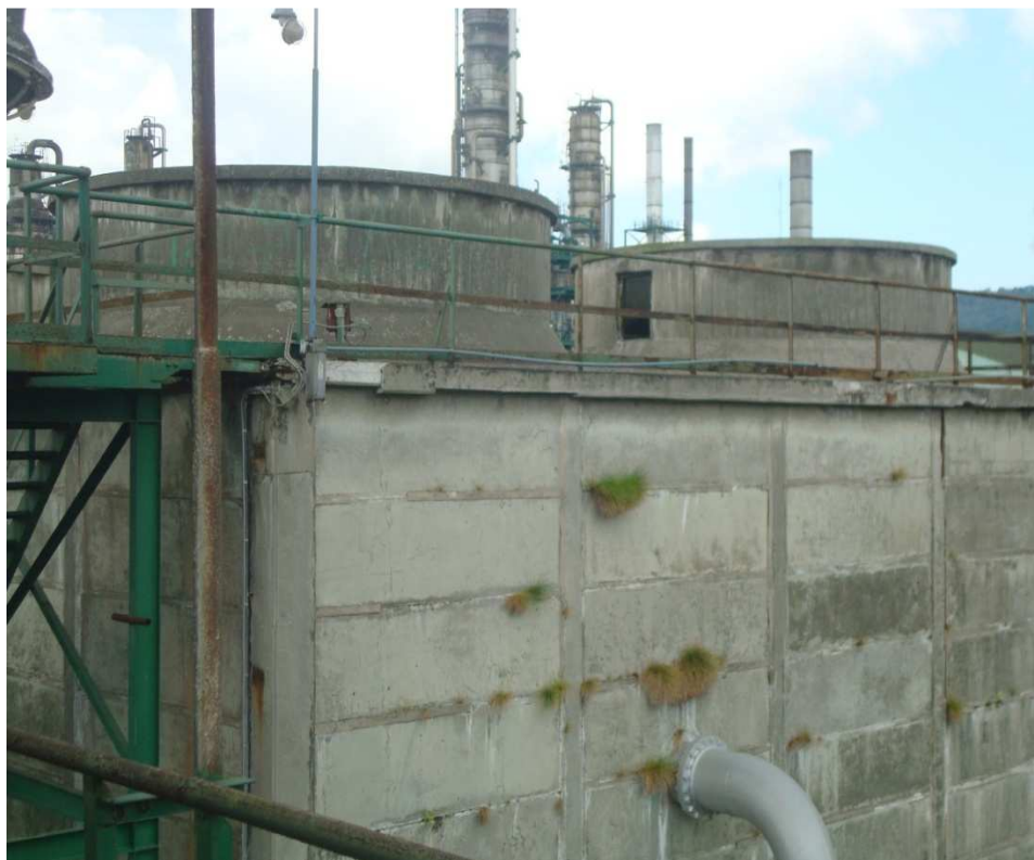
FOTO 2.3.1-1.Estado de la parte externa de la Torre Y-ME3003B DE LA REE
