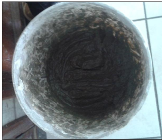
Fotografía 15. Pasta de fibrocemento
