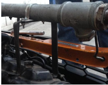
Figura 26-5. Montaje del reactor en los soportes de fijación
