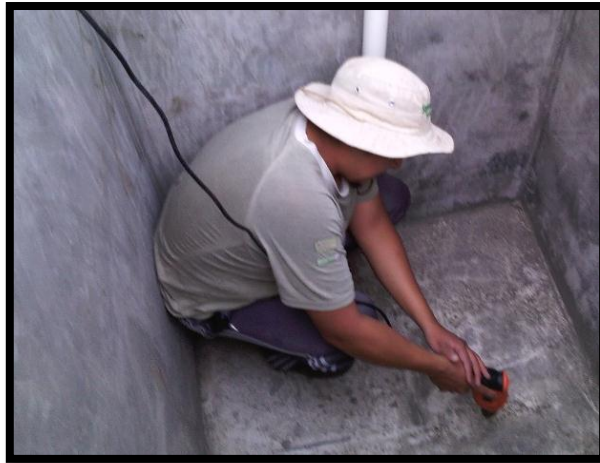
Figura 14.3 Perforación de tubería para drenaje del Filtro.
