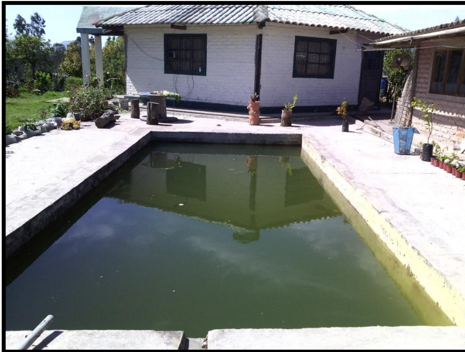
Figura 5.1 Reservoirio de Hormigón de Agua de Riego de la Granja Villacreces. Elaborado por: Victor Villacres, 2017
