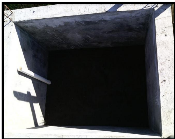
Figura 18.3 Tubo de dos pulgadas completo para aliviadero. Elaborado por: Victor Villacres, 2016
