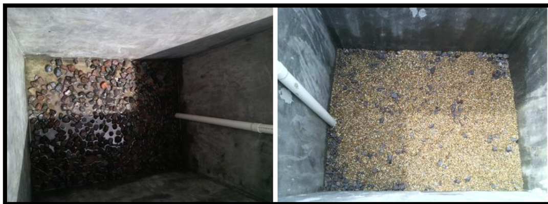
Figura 20.3 Armado del Lecho de soporte del Filtro.
