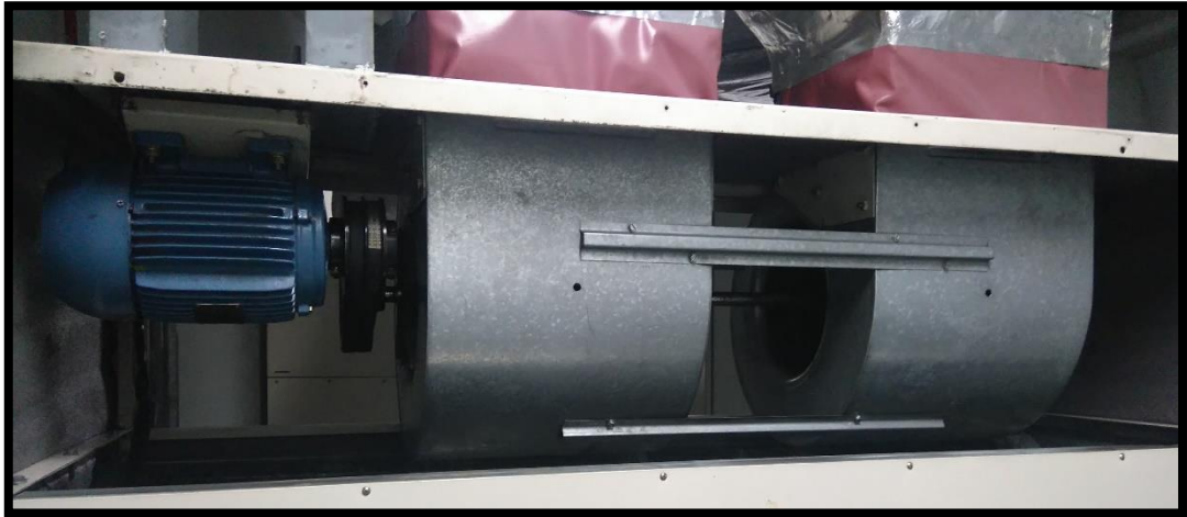
Figura 8-1 Módulo de ventilación Realizado por: Gamboa. A. 2017.
