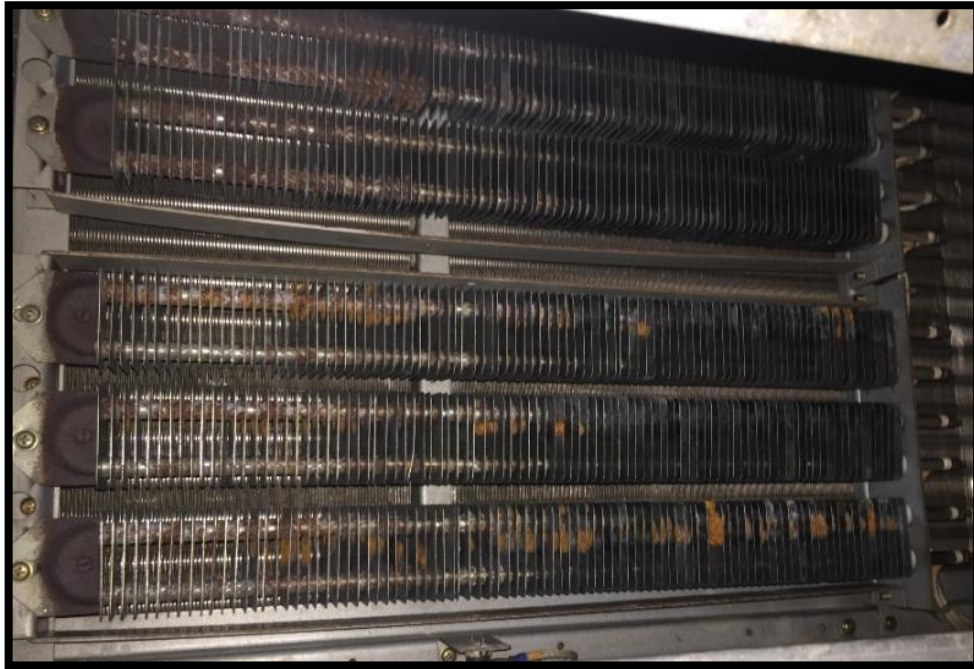
Figura 10-1 Resistencias de calentamiento Electricfor Realizado por: Gamboa. A. 2017.
