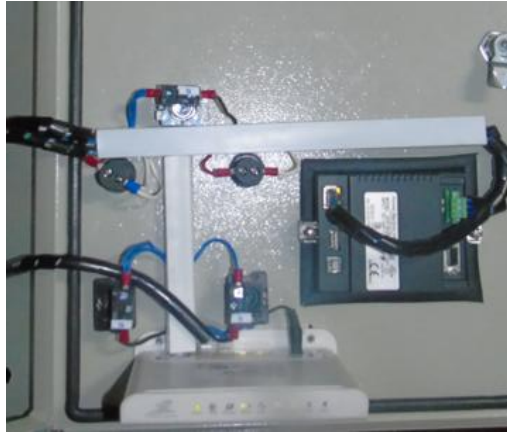
Figura 18 - 2 Conexión pantalla HMI y Router Realizado por: MOYOTA, Byron; GUILCAPI, Lidia, 2017
