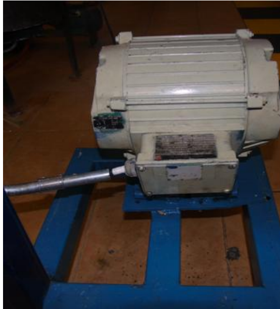
Figura 9 - 2 Colocación Motor de 5HP Realizado por: MOYOTA, Byron; GUILCAPI, Lidia, 2017
