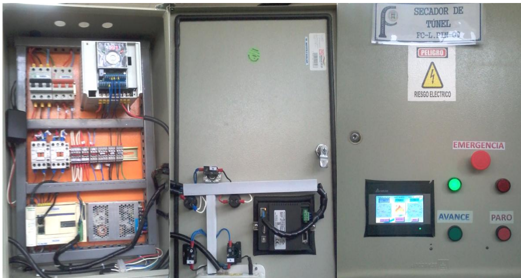
Figura 19 - 2 Tablero de Control y Mando terminado Realizado por: MOYOTA, Byron; GUILCAPI, Lidia, 2017
