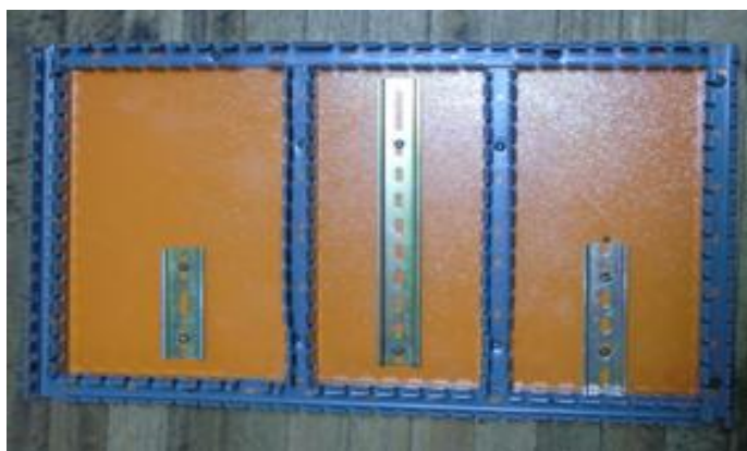
Figura 14 - 2 Colocamos Riel din y Canaletas en el tablero de Control Realizado por: MOYOTA, Byron; GUILCAPI, Lidia, 2017
