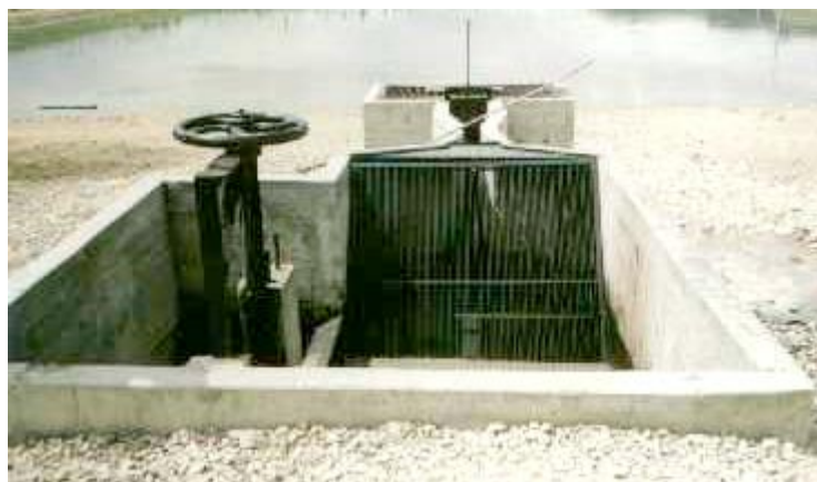
Figura 4 Pretratamiento con Rejillas
