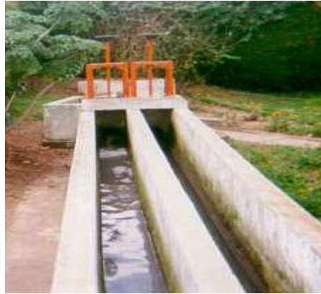
Figura 5 Desarenador
