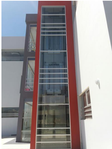
Figura 11. Ascensor Facultad de Mecánica.
