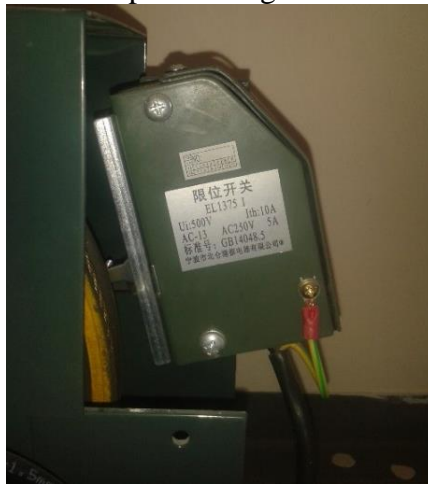
Figura 29. Interruptor del regulador de velocidad.
