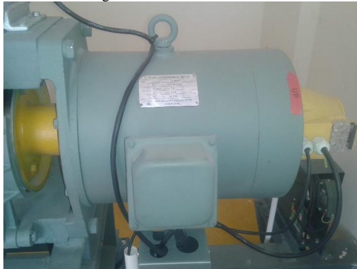
Figura 22. Motor del ascensor
