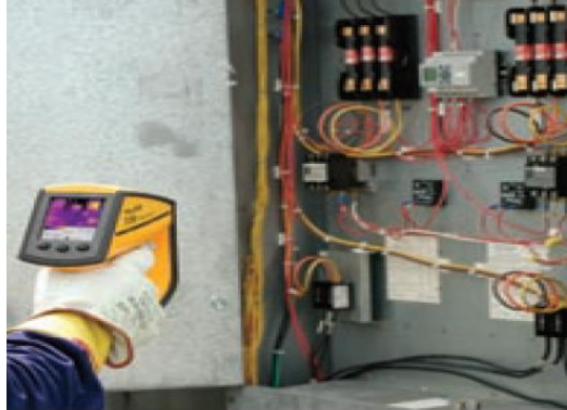
Figura 21. Inspección en tableros de control
