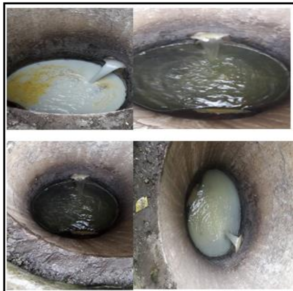
Figura 23-2: Descarga de agua residual al sistema de alcantarillado público
