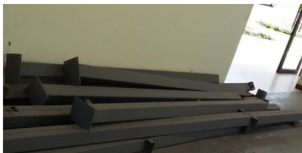
Figura 8. Almacenaje inadecuado. Fuente: Autor
