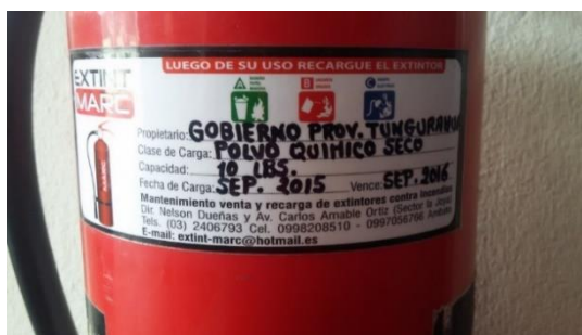
Figura 31. Extintor de fuego – polvo químico seco. Fuente: Autor
