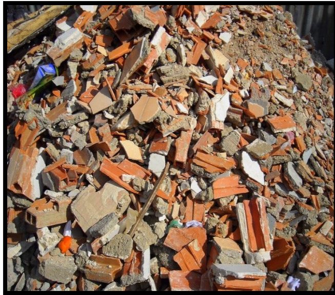
Figura 4-1: Residuos de construcción y demolición
