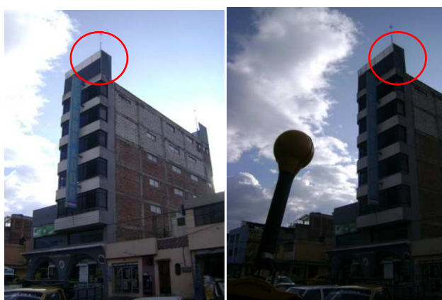
Fig. 4.56 Monitoreo del lugar aledaño a la Radiobase
