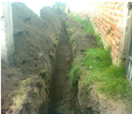
RASANTEO DE ZANJA A MANO
