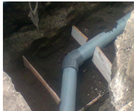
INSTALACIÓN Y PRUEBA DE TUBERIA TUBERIA PVC-P-EC 160 MM (0.8 MPa)
