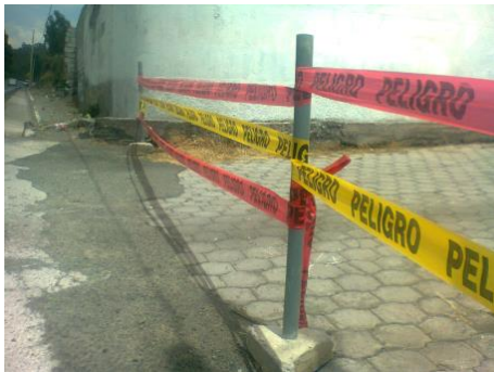
CINTA DE SEÑALIZACIÓN AGUA POTABLE
