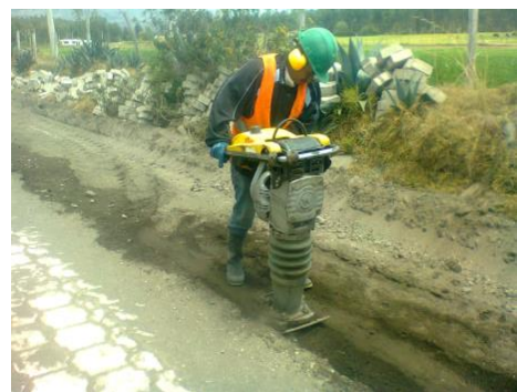
RELLENO COMPACTADO CON MAT. EXCAVACIÓN
