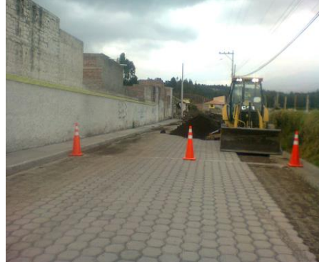
EXCAVACIÓN DE MAQUINA EN TIERRA
