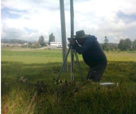
REPLANTEO Y NIVELACIÓN
