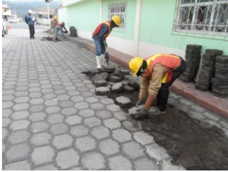
INSTALACION DE ADOQUIN DE CEMENTO (MATERIAL EXISTENTE)
