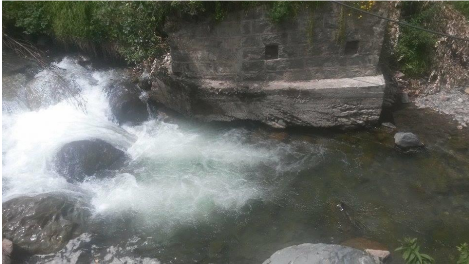
A 3: Bajo del puente de la vía que comunica la Comunidad de PELTEC con la comunidad de Alao
