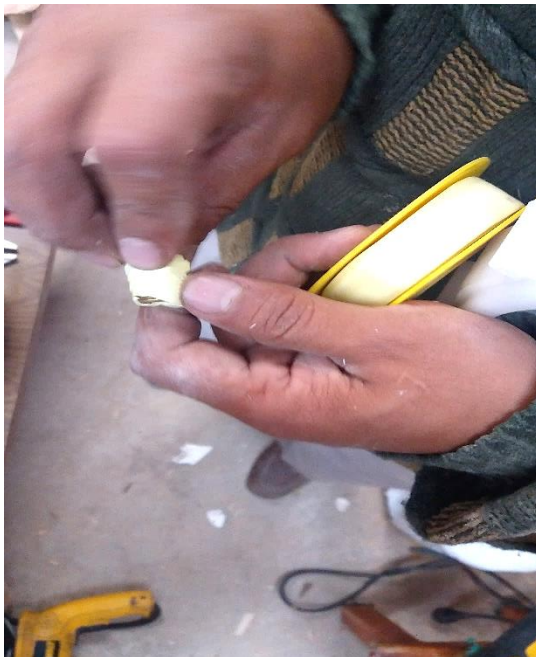
Fotografía 9 Unión cubierta de teflón.
