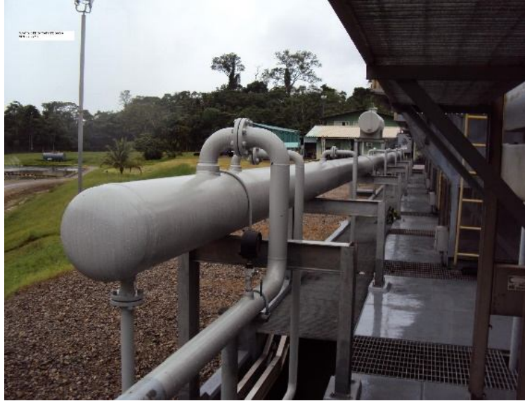
Figura 1-3. Distribuidor (manifold) del sistema de generación. Fuente: REPSOL Bloque 16. Elaborado por Cortez P. (2015)
