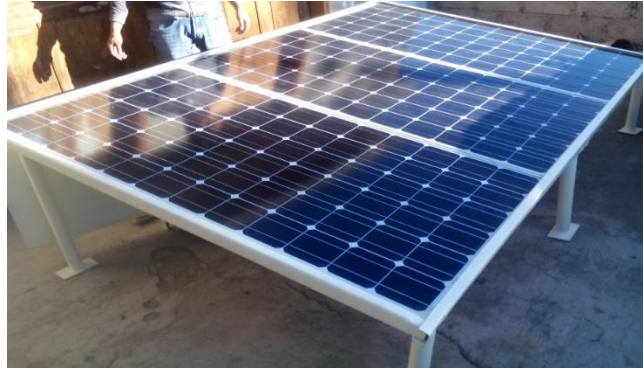
Figura 11-2 Estructura final para los paneles solares. Fuente: LLAMUCA, Alex; CAISAGUANO, Alex, 2016
