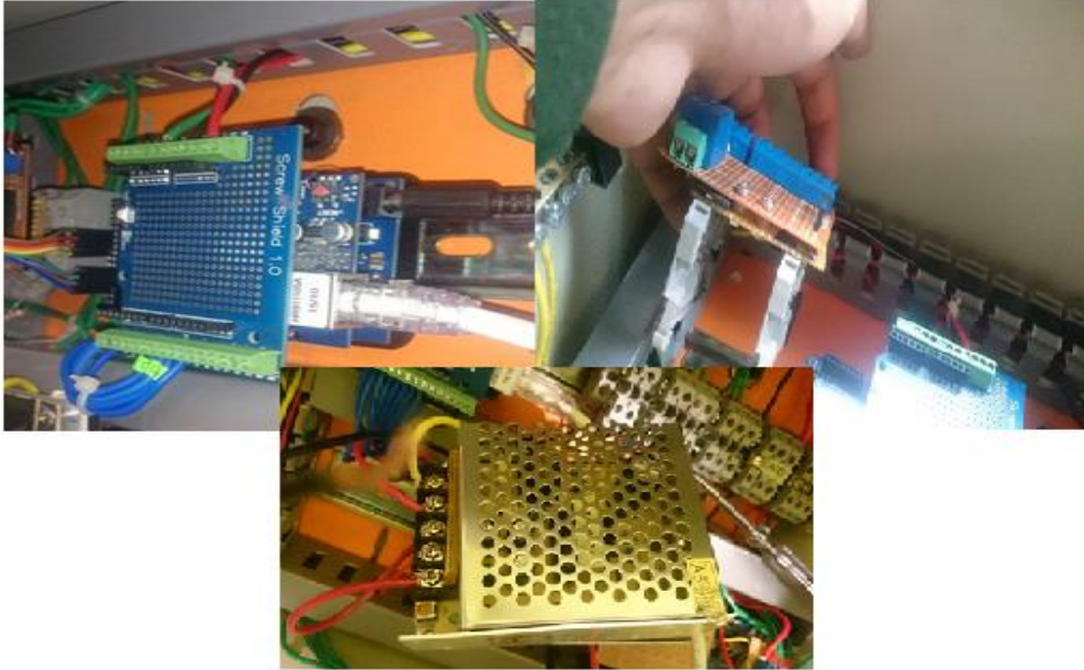
Figura 44-2 Colocación de dispositivos electrónicos en el gabinete de control.
