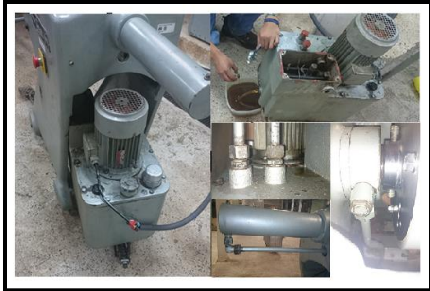
Figura 18-2 Desmontaje de la unidad hidráulica
