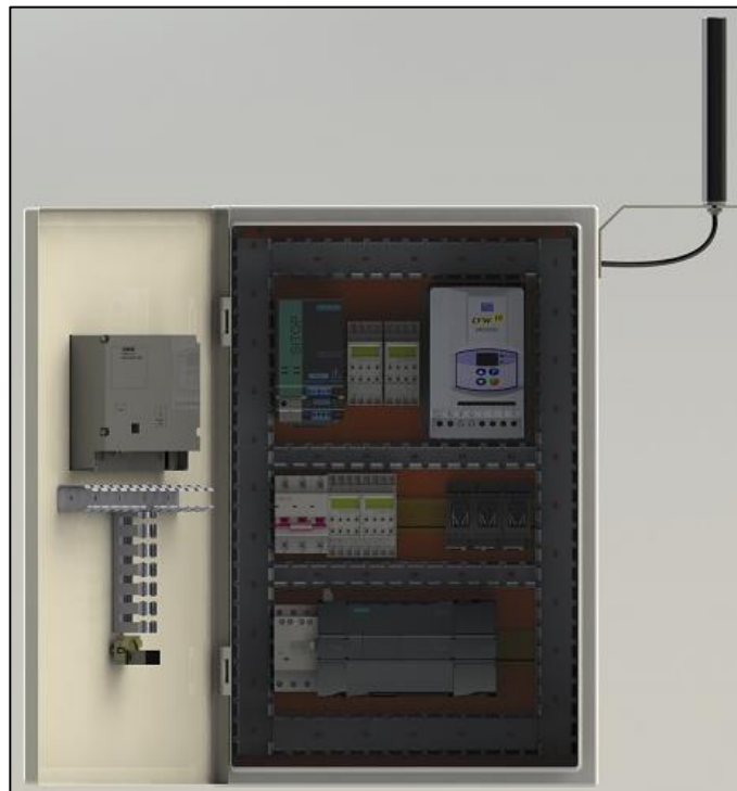
Figura 29-3: Montaje del módulo GSM y Antena
