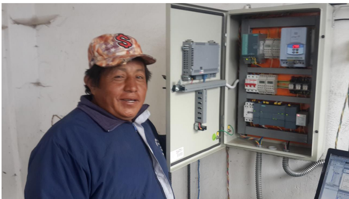
Usuarios de Sistema de riego, encargados del mantenimiento del mismo
