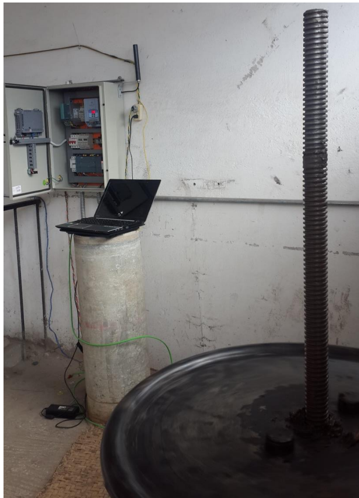
Programación del tablero de control para la ejecución del proceso automático
