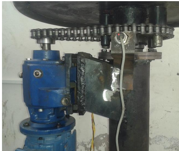
Figura 32-3: Sensor inductivo en la válvula de compuerta Fuente: SILVA CONDE, Angel Alberto, 2016
