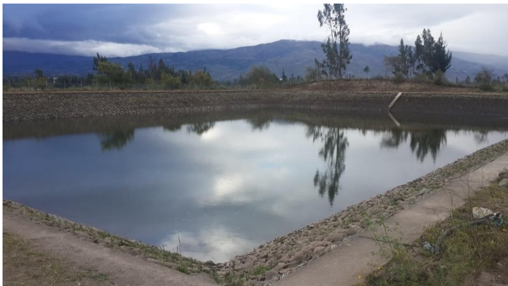
Figura 7-2: Reservorio 66 de sistema de riego Ch-G
