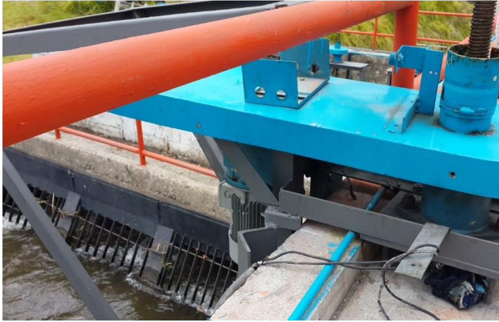
Figura 4-2: Inicio del canal principal con rejillas de protección Fuente: SILVA CONDE, Angel Alberto, 2016
