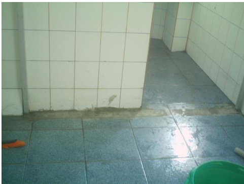
Foto 3. Retiro de puertas corredizas y taponamiento de las canaletas
