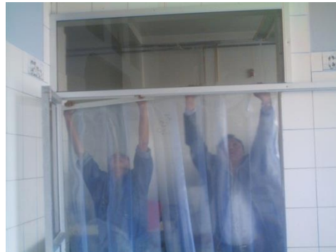
Foto 4. Colocación De Cortinas Hawaianas
