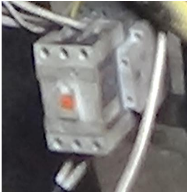
Gráfico 11. Transformador para una máquina prensadora.
