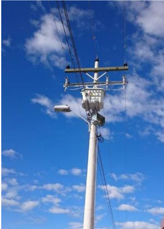
Figura 9 - 3: Obra finalizada, montaje transformador trifásico
