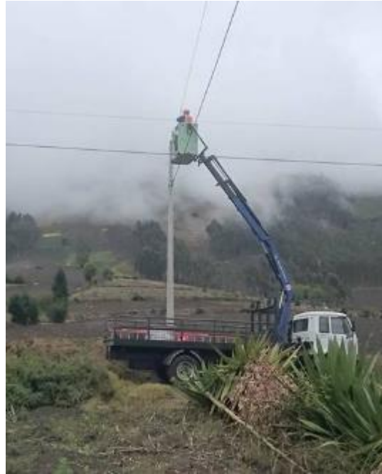
Figura 7 - 3: Instalación de una nueva red eléctrica
