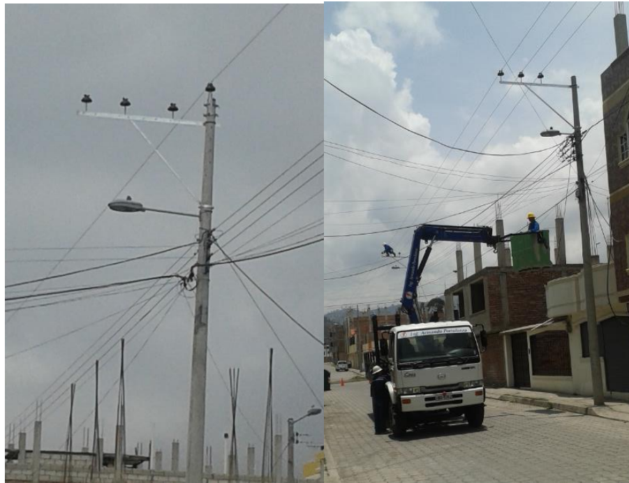
Figura 8 - 3: Montaje de red trifásica proyecto pozos Riobamba
