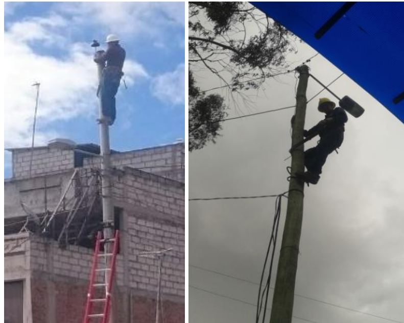
Figura 10 - 3: Montaje de aisladores - lámparas
