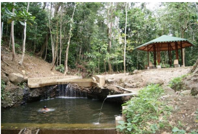
Foto N°3: Dique de la Cascada Wampim
