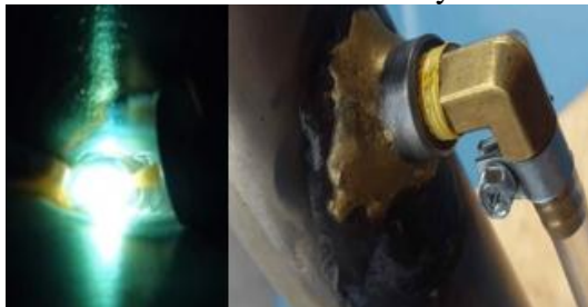
Figura 95. Soldadura del tubo de llenado y visor de combustible
