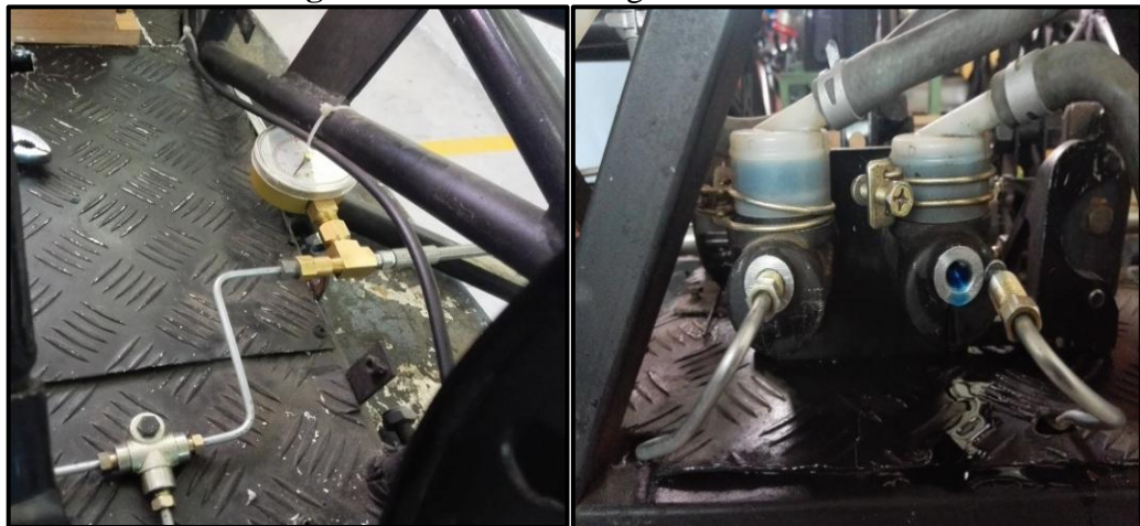
Figura 66 . Control de fugas en el circuito.
