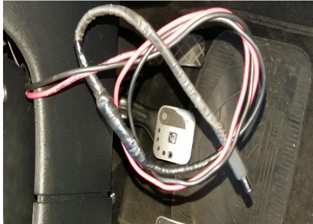
Figura 34. Conexión del rectificador de voltaje
