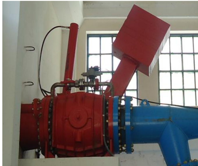
Figura 14. Válvula de Entrada de Agua
