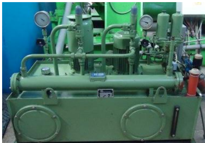
Figura 22. Sistema de Lubricación de los Cojinetes
