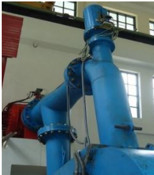
Figura 15. Inyector
