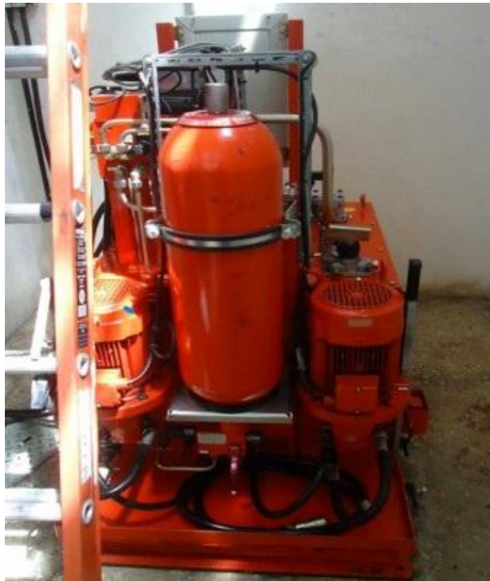
Figura 20. Sistema Hidráulico de la Válvula Principal
