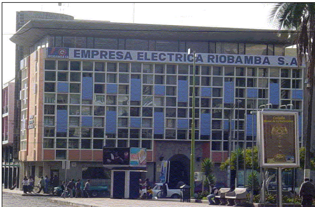
Figura 3. EDIFICIO MATRIZ EMPRESA ELECTRICA RIOBAMABA SA.
