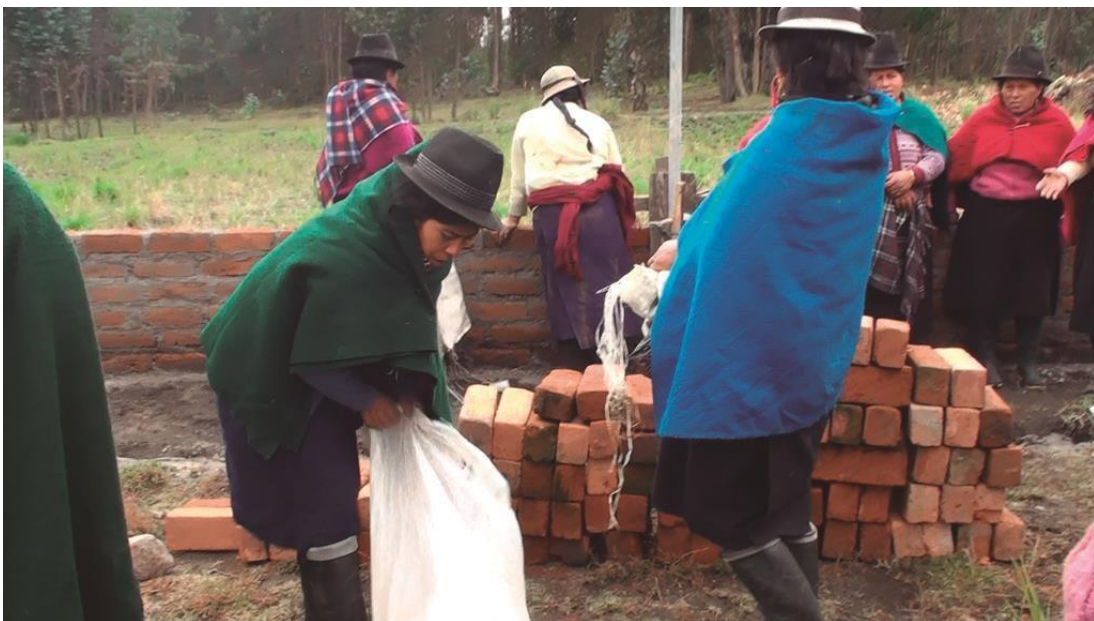
Figura 4.3: Socias trabajando en el cerramiento de su terreno
