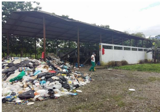
Ilustración 15: Área de reciclaje Fuente: EMMAI-BCP-EP
