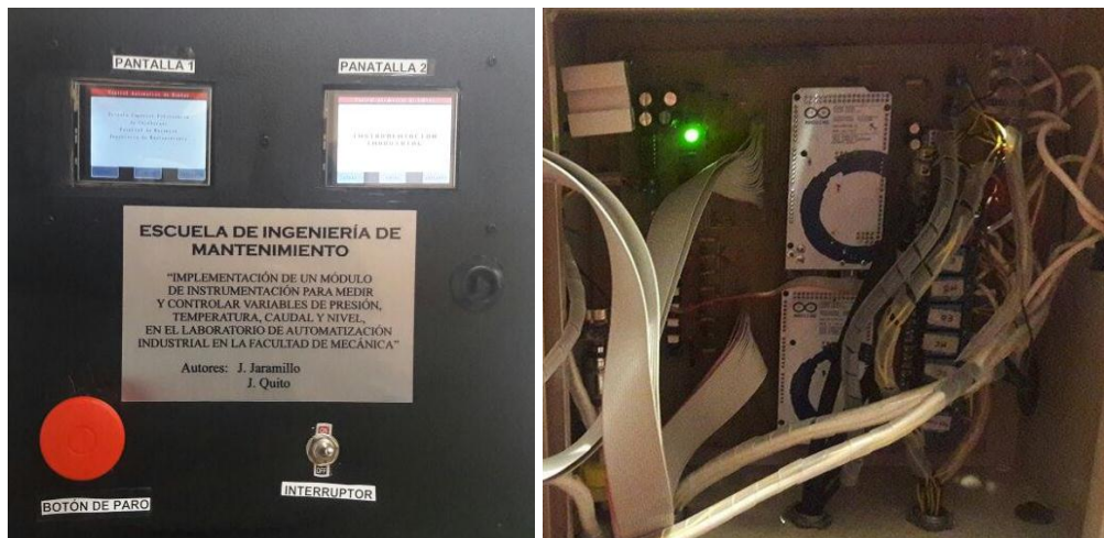
Figura 38. Encendido del sistema de control.
