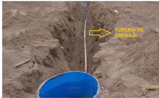
**Figura 3-2. Instalación del lisímetro.**
