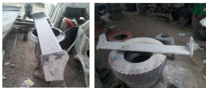
Figura 100. Colocación de masilla plástica sobre el spoiler y alerón
