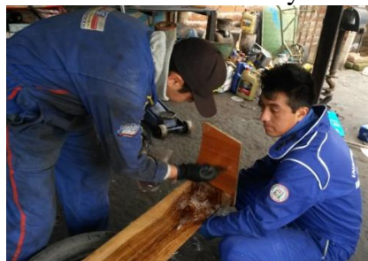
Figura 97. Colocación de las láminas de cabuya sobre las derivas laterales
