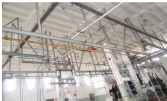
Figura 42-3: Limpieza de canal. Realizado por: Paul Vega, 2016
