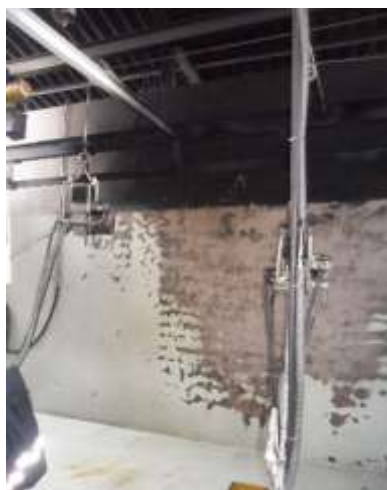
Figura 31-3: Limpieza de lana o cerdas incineradas. Realizado por: Paul Vega, 2016
