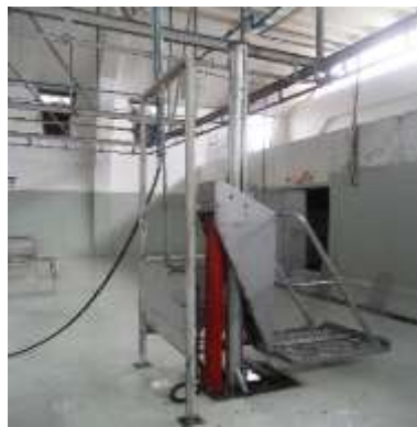
Figura 19-3: Limpieza de canal Realizado por: Paul Vega, 2016
