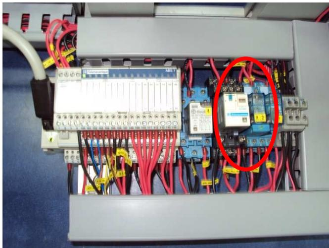
**Fig. V.59 Relé Sustituido**
