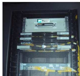
| Router y conversor óptico-eléctrico
