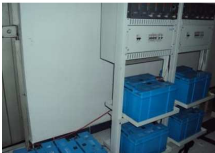
| Sistema de energía y respaldos
