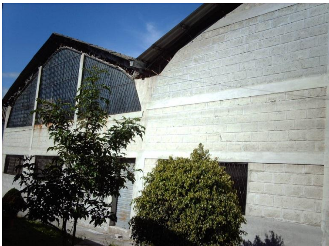
Anexo No. 5 Área de contabilidad y de administración
