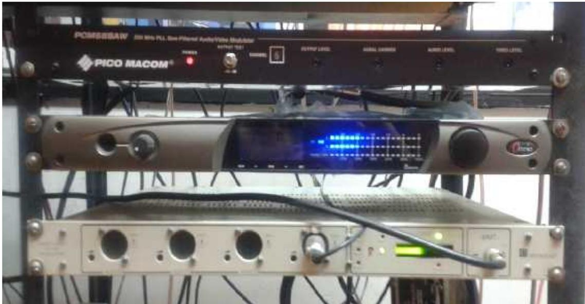
**Figura 44-2.** Transmisor UHF ubicado en el Guaranda-5Tv.
