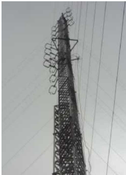
Arreglos de antenas de radiodifusión
