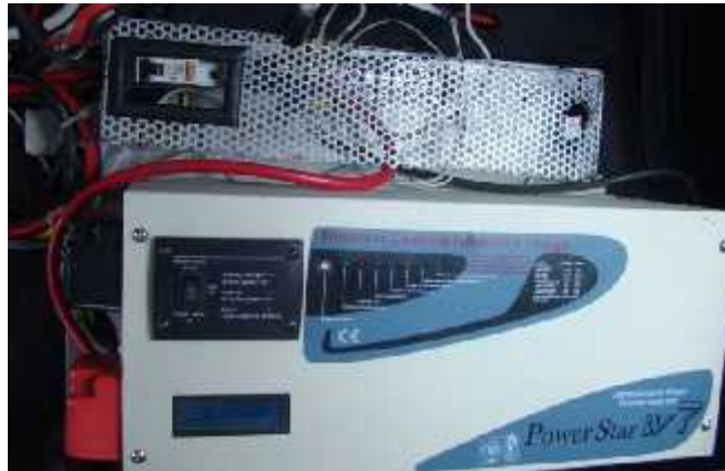
Figura 33-1.- Sistema de alimentación e inversor de onda senoidal de la EM
