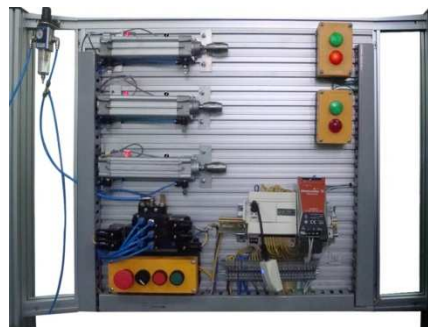
Figura IV. 34 Foco Rojo1 encendido en el tablero de aluminio
