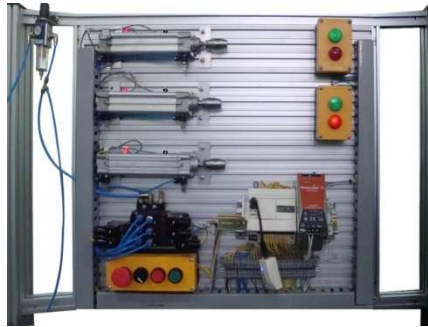
Figura IV. 42 Foco Rojo2 encendido en el tablero de aluminio
